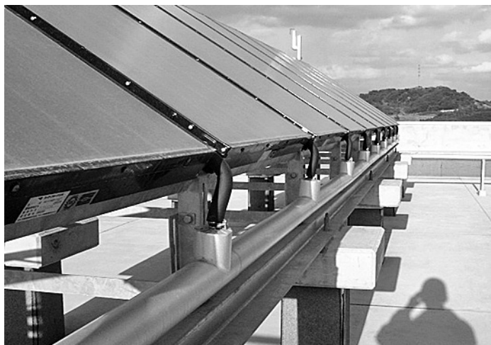
Photo1：集熱配管ヘッダー部の施工例
