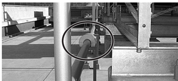
Photo3：自動空気弁取付例
