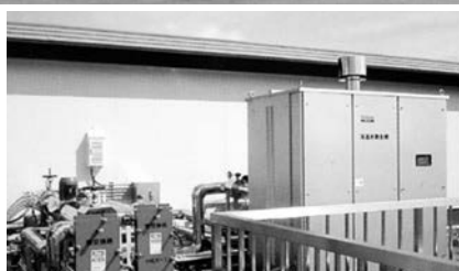
補助ボイラー付温水焚吸収冷温水機
