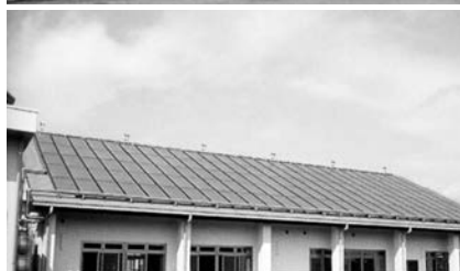
屋根への太陽集熱器設置状況
