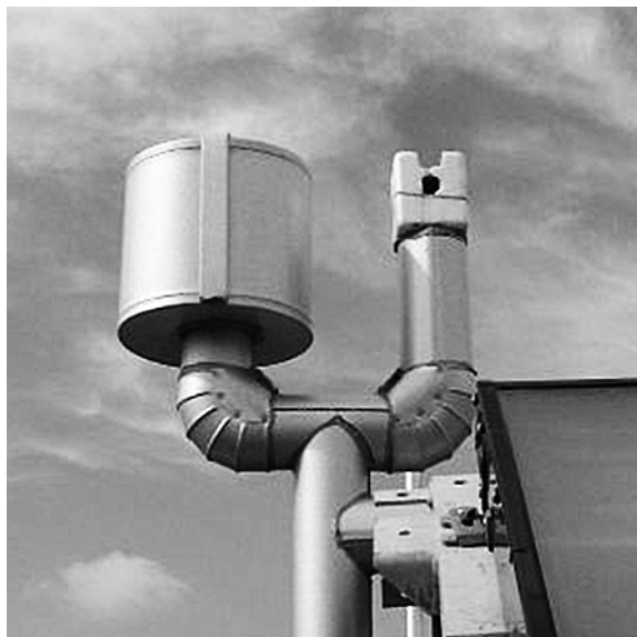
Photo4：自動空気弁
