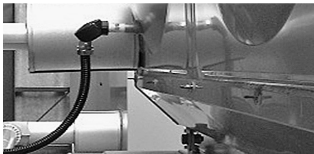
Photo4：低温センサー取付例
