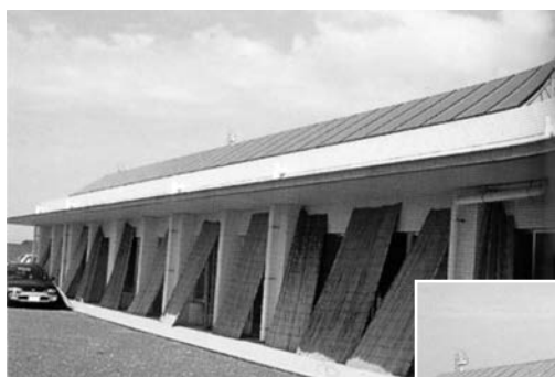
屋根への太陽集熱器設置
