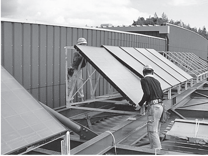
Photo2：「設置下側」の目印
