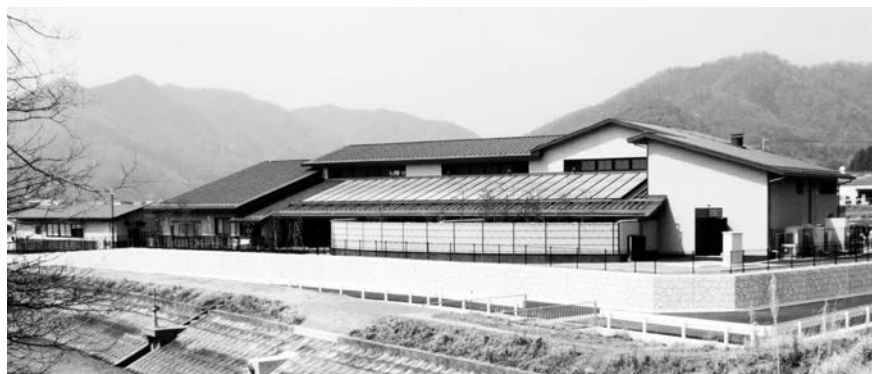
建物遠景と太陽集熱器設置状況
