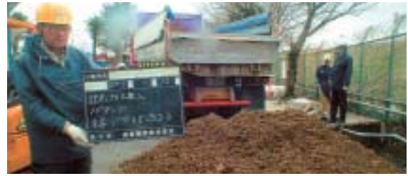
土壌入れ替え作業(島田製作所)
