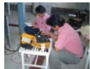
プーケットで電線の点検・復旧に取り組むTYE従業員
