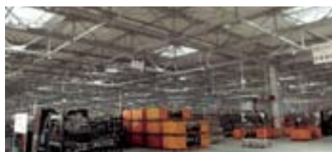
天窓の採光で照明なしでも明るい
